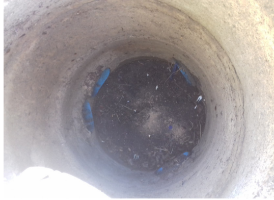
Pou d'infiltració aterrat
