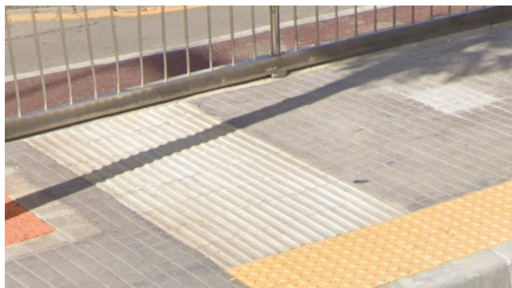
Detalle de pavimentación resultante
