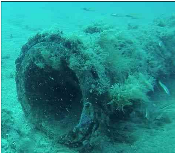
Extremo colector difusor (lado N a -30 m y lado S a -32 m)
