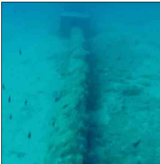
Ausencia vegetación en difusores y tramo final emisario
