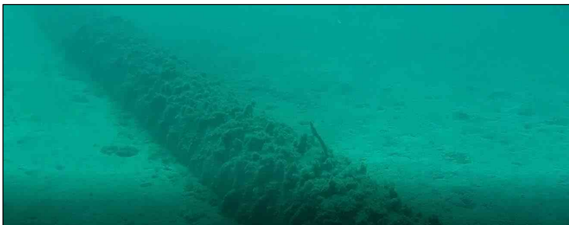
Detalle ausencia vegetación en los primeros metros del asentamiento emisario sobre fondo marino (hasta aprox. 1.700 metros)
