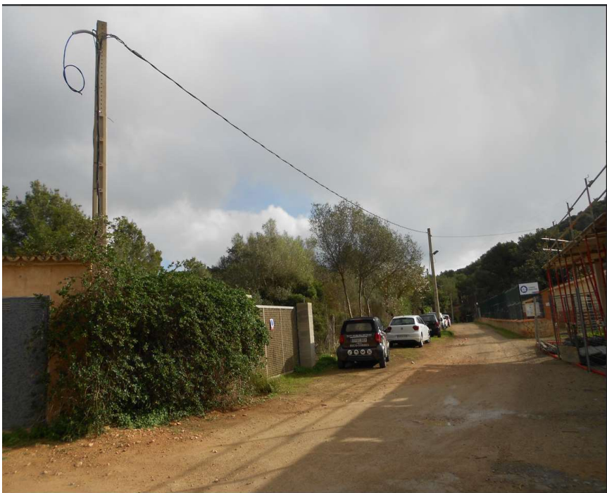
Al centre, pal existent on situar nou punt de servei
