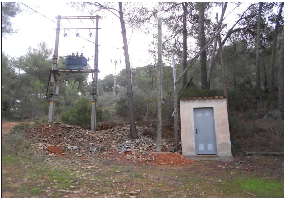
Escomesa actual de sa canera i caseta de comptadors
